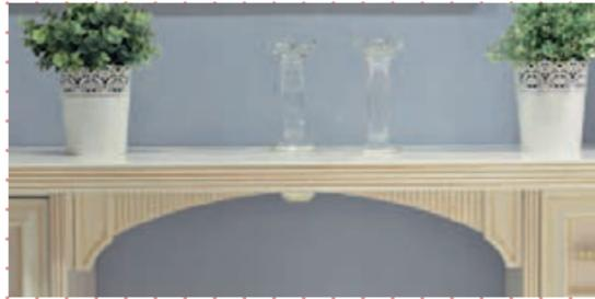
Столешница туалетного столика по периметру отделана рельефной торцевой кромкой толщиной 45 мм и украшена декоративной фрезерованной аркой.
